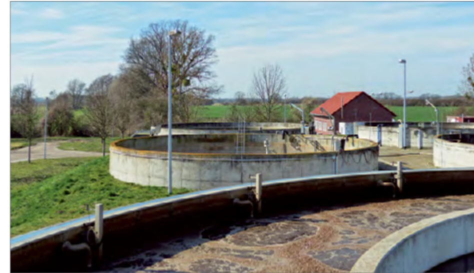
Klärbecken der Kläranlage Loburg des AWZ Elbe-Fläming.
