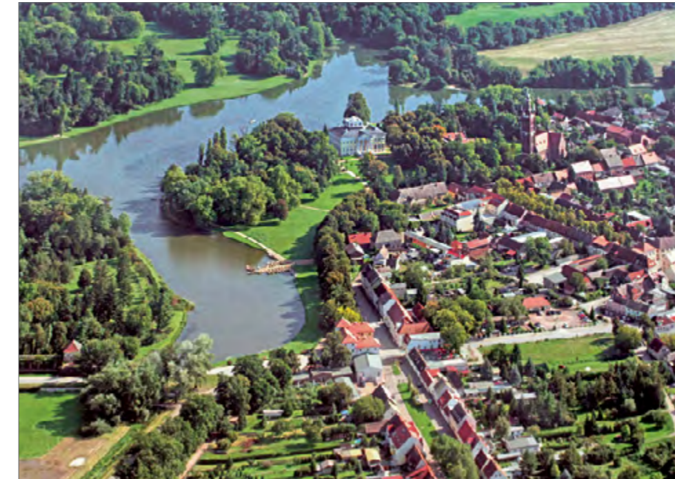
Weltkulturerbe: der Wörlitzer Park. Das Wasserwerk Oranienbaum versorgt Wörlitz, Oranienbaum und Vockerode.
