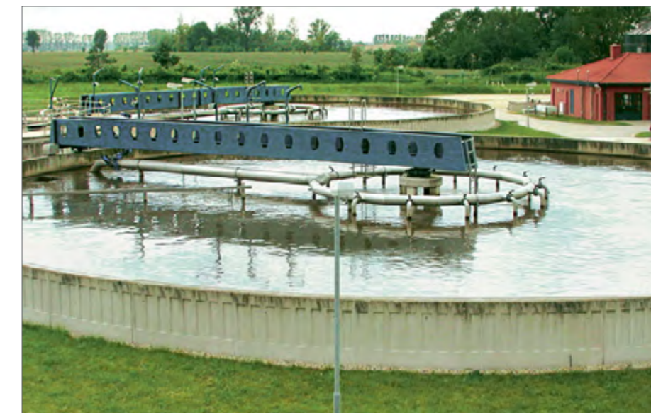
Vorklärbecken auf der vollbiologischen Zentralkläranlage Zerbst der SUT GmbH.
