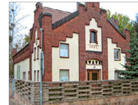
Aus dem Jahr 1909 stammt das Betriebsgebäude der alten Kläranlage Zerbst in der Käasperstraße.
