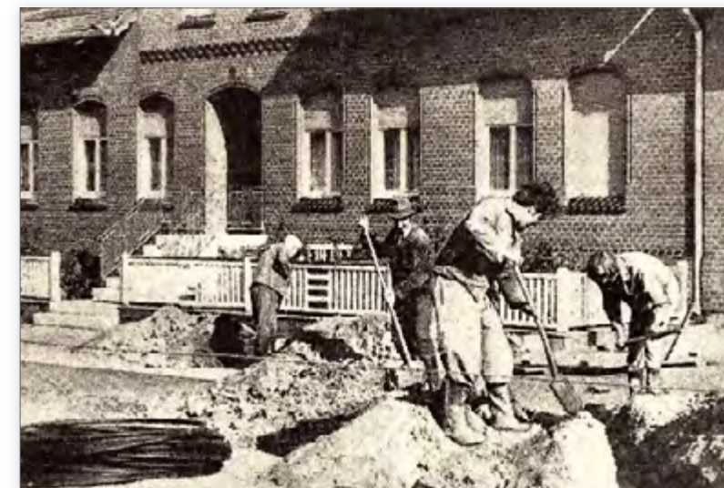
Arbeiten im Landprogramm der DDR zum Anschluss an die zentrale Wasserversorgung.
