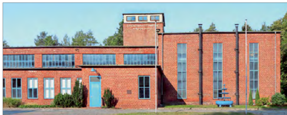
Das Wasserwerk Colbitz der TWM GmbH versorgt seit 2004 ein Viertel der Region Haldensleben mit Trinkwasser.
