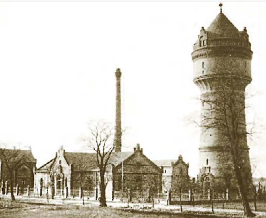
Ansicht des Wasserwerkes in Zerbst von 1894.
