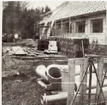
Die Richtkrone wurde gestern auf das neue Wasserwerk gesetzt.
