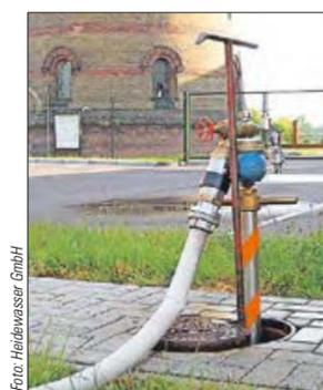
Heidewasser-Standrohr mit verbautem Systemtrenner.
