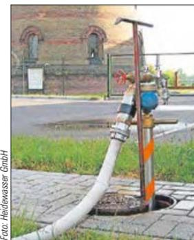
Heidewasser-Standrohr mit verbautem Systemtrenner.
