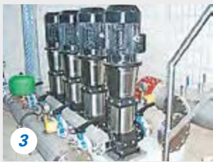
Gelungene Symbiose aus Natur und Technik – die Abläufe bei der Trinkwasserproduktion. 1 Regelmäßig entnehmen Mitarbeiter der TWM Wasserproben. 2 Immer genug Wasservorrat in riesigen Hochbehältern. 3 Futuristische Optik: Druckerhöhungsanlagen. 4 Grundwasser läuft bei seiner „Sauerstoffkur“ über Kaskaden – Eisen- und Manganablagerungen färben sie orangebraun.
