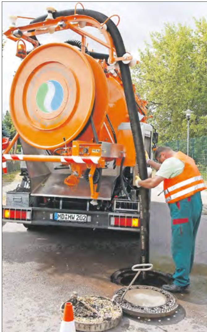
Kanalnetzarbeiter des Heidewasser-Meisterbereiches Möckern reinigen die Kanäle mit modernen Hochdruckspülwagen. Die Anwohner werden zuvor mittels Handzettel informiert.
