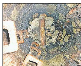
Bilder aus der Unterwelt. Die Kamerabefahrungen lassen die Schäden an den Kanälen und Schächten deutlich erkennbar werden. Hier muss repariert bzw. neu gebaut werden.
