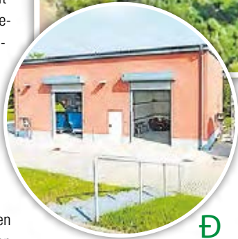
TM Die Kläranlage Loburg aus der Vogelperspektive. Ⓓ Im Rechenhaus der Kläranlage (oberes Gebäude im Luftbild) sind Rechen und Sandfang in einer Anlage vereint. Sie reinigen das Schmutzwasser mechanisch, bevor es in die nächste Stufe – die biologische Reinigung – überführt wird. ½ Den vom Rechen aufgefangenen Feststoffen wird das Wasser entzogen und sie landen im Container. ± Aus dem Ablauf des Sandfangs gelangt der Sand ebenfalls in einen separaten Container und wird anschließend durch eine Spezialfirma entsorgt.
