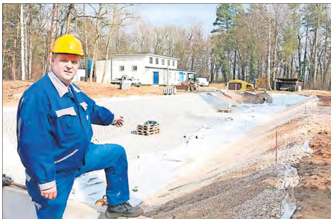
Heidewasser-Mitarbeiter Steffen Lönning auf der Baustelle der sanierten Filtrerrückspülwasser-Absetzbecken.
