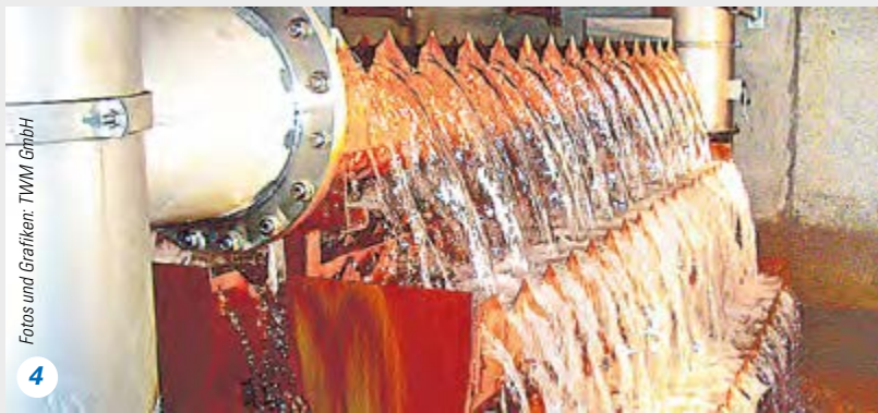
Gelungene Symbiose aus Natur und Technik – die Abläufe bei der Trinkwasserproduktion. 1 Regelmäßig entnehmen Mitarbeiter der TWM Wasserproben. 2 Immer genug Wasservorrat in riesigen Hochbehältern. 3 Futuristische Optik: Druckerhöhungsanlagen. 4 Grundwasser läuft bei seiner „Sauerstoffkur“ über Kaskaden – Eisen- und Manganablagerungen färben sie orangebraun.
