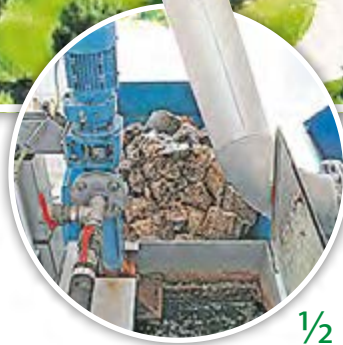
TM Die Kläranlage Loburg aus der Vogelperspektive. Ⓓ Im Rechenhaus der Kläranlage (oberes Gebäude im Luftbild) sind Rechen und Sandfang in einer Anlage vereint. Sie reinigen das Schmutzwasser mechanisch, bevor es in die nächste Stufe – die biologische Reinigung – überführt wird. ½ Den vom Rechen aufgefangenen Feststoffen wird das Wasser entzogen und sie landen im Container. ± Aus dem Ablauf des Sandfangs gelangt der Sand ebenfalls in einen separaten Container und wird anschließend durch eine Spezialfirma entsorgt.
