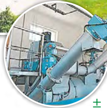
TM Die Kläranlage Loburg aus der Vogelperspektive. Ⓓ Im Rechenhaus der Kläranlage (oberes Gebäude im Luftbild) sind Rechen und Sandfang in einer Anlage vereint. Sie reinigen das Schmutzwasser mechanisch, bevor es in die nächste Stufe – die biologische Reinigung – überführt wird. ½ Den vom Rechen aufgefangenen Feststoffen wird das Wasser entzogen und sie landen im Container. ± Aus dem Ablauf des Sandfangs gelangt der Sand ebenfalls in einen separaten Container und wird anschließend durch eine Spezialfirma entsorgt.
