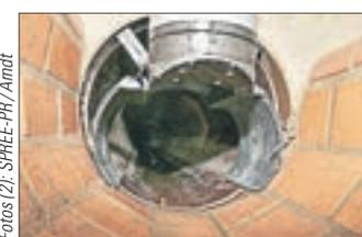
Rattenfalle mit ausgefahrenen Bolzen (oben) und nach Einbau im Abwasserkanal.
