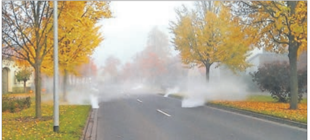
Eine Szene wie aus einem Gruselfilm. Die Benebelung des Kanalnetzes in Gommern ist aber gänzlich ungefährlich und dient lediglich zur Überprüfung der Niederschlagswasserableitungen von Grundstücken.
