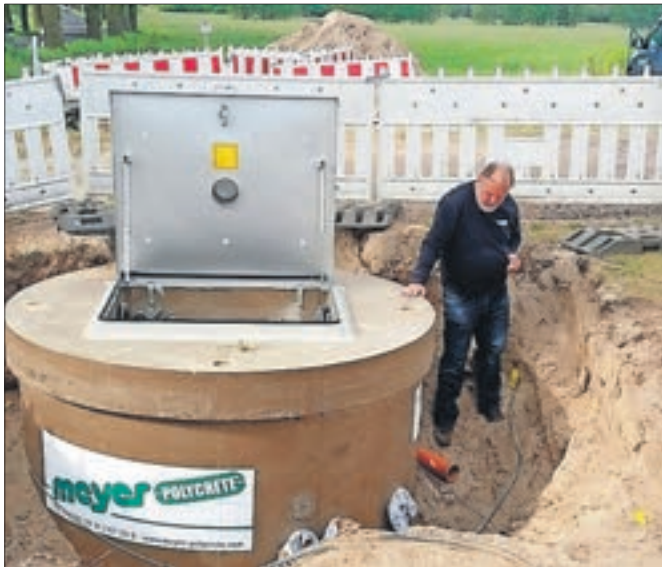
Ein neues Pumpwerk sorgt künftig für den stetigen Abwasserstrom von Ragösen, OT Krakau, zur Kläranlage Hundeluft.
