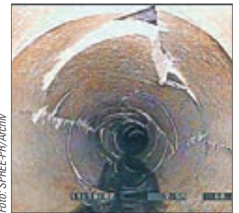
Scherbenbildung im Kanal: Hier muss gehandelt werden.
