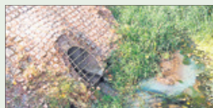
Waschwasser im Auslauf eines Regenwasserkanals.
