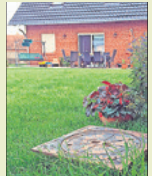
Diese Schachtabdeckung ist gut zugänglich.
