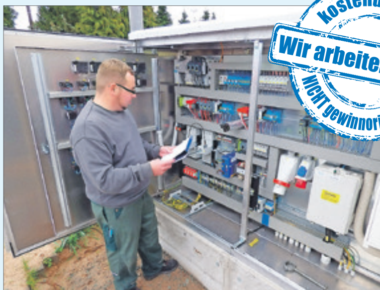
Tobias Reinisch kontrolliert einen der neuen Schaltschränke, die für den Anschluss der Pumpwerke des AVH errichtet werden mussten. Foto: AVH
