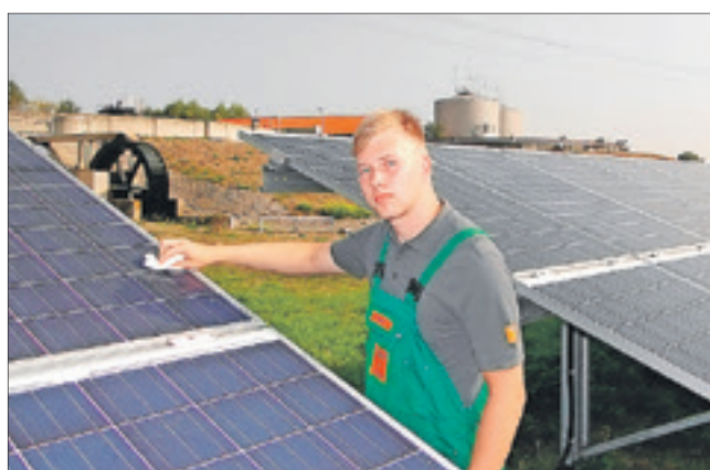
Azubi Eike Hetke schaut bei der Photovoltaikanlage regelmäßig nach dem Rechten und entfernt grobe Verschmutzungen. Foto: AVH
