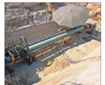
Grabenloser Rohrvortrieb an der Bahnstrecke Roßlau-Wiesenburg. Foto: Heidewasser GmbH
