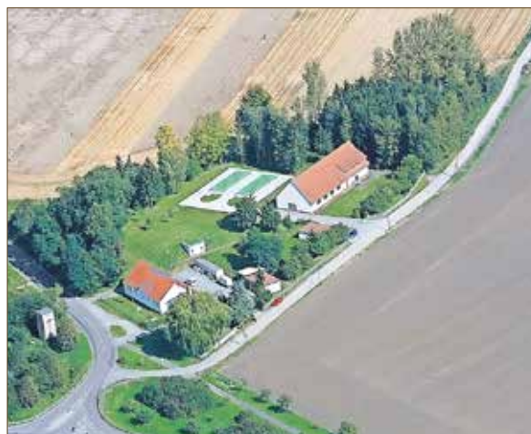
Das Haldensleber Wasserwerk aus der Vogelperspektive.
