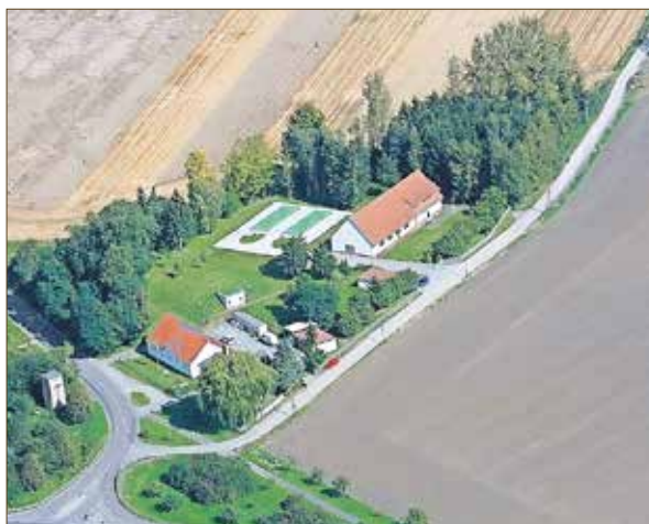
Das Haldensleber Wasserwerk aus der Vogelperspektive.
