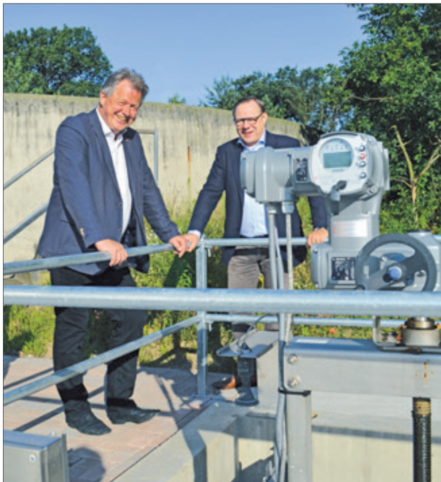
Partnerschaftliches Bündnis in der Abwasserentsorgung: AZV-Geschäftsführer Frank von Holly und Michael Schönewolf, Geschäftsführer der AGS GmbH, vor der neuen Anlage in Möckern.
