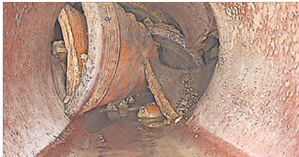
Bei massiven Schäden wie solchen Rohreinbrüchen wird natürlich gehandelt, sobald der Eigenbetrieb Kenntnis von dem Schaden erlangt.
