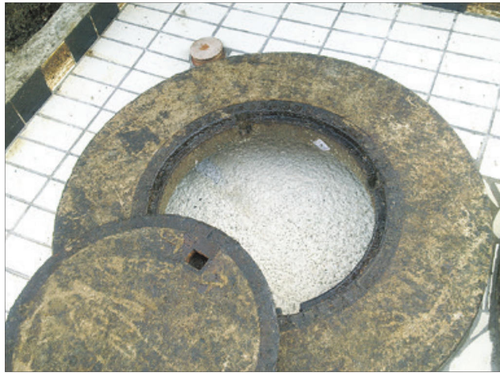
Unternehmen in deren Abwasser sehr viel Fett und Öl enthalten ist, benötigen einen vorgeschalteten Fettscheider. Dessen reibungsloser Betrieb wird vom AWZ kontrolliert. Ein Verzeichnis dokumentiert alle derartigen so genannten Indirekteinleiter.
