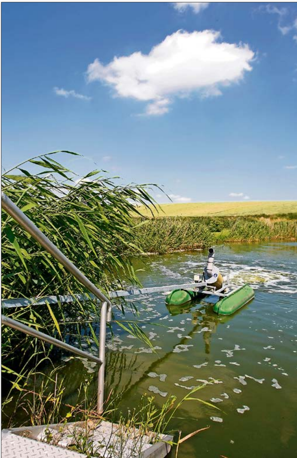
Blick auf die Teichkläranlage in Nordgermersleben, in der die Abwässer von knapp 5.000 Einwohnern gereinigt werden.
