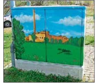
Regionale Industriegeschichte, auf Pumpwerk gebannt. Zu sehen ist die Allingerleber Zuckerfabrik im Gebiet des Behnsdorfer Abwasserverbandes. Foto: AZV
