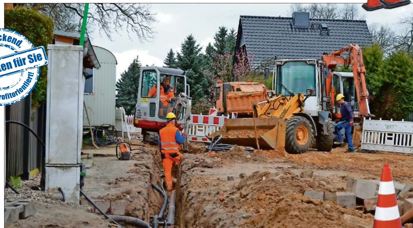
Der bisherige Mischwasserkanal wurde im Zuge der Erneuerung der Straße „Am Kamp“ in einen Regenwasser- und einen Schmutzwasserkanal getrennt.
