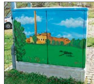
Regionale Industriegeschichte, auf Pumpwerk gebannt. Zu sehen ist die Allingerleber Zuckerfabrik im Gebiet des Behnsdorfer Abwasserverbandes. Foto: AZV
