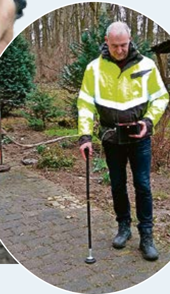
Hören – Sehen – Wasserverluste finden: Heiko Bartel lokalisiert sie mit einem Bodenmikrofon. Fotos (3): Heidewasser GmbH/SPREE-PR
