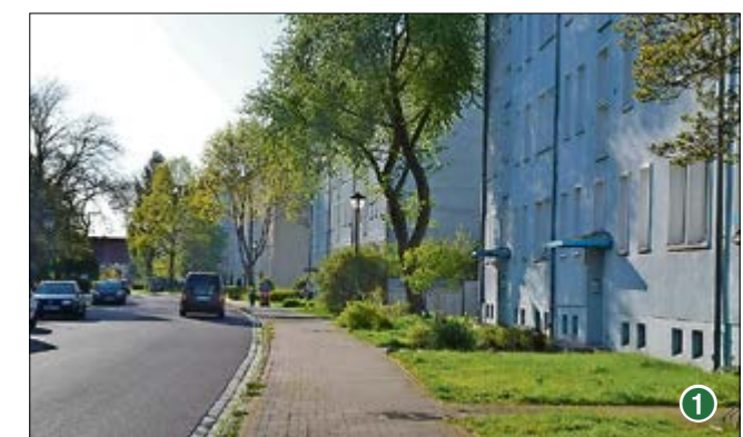
In der Albert-Schweitzer-Straße wird demnächst ein neuer Abwasserkanal unter dem Fußweg verlegt. Fotos (2): Spree-PR/Wähler
