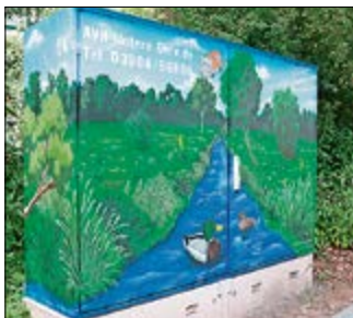
Gesehen in Haldensleben: Ein Pumpwerk, das sich seiner Umwelt anpasst und optisch beinahe mit dem Hintergrund verschmilzt. Foto: SPREE-PR/Arndt
