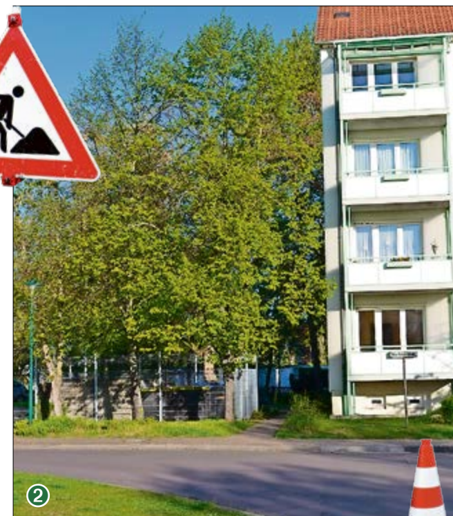
Unter diesem Containerplatz wird ein Kanal gelegt, ohne dass Schachtarbeiten nötig sind.
