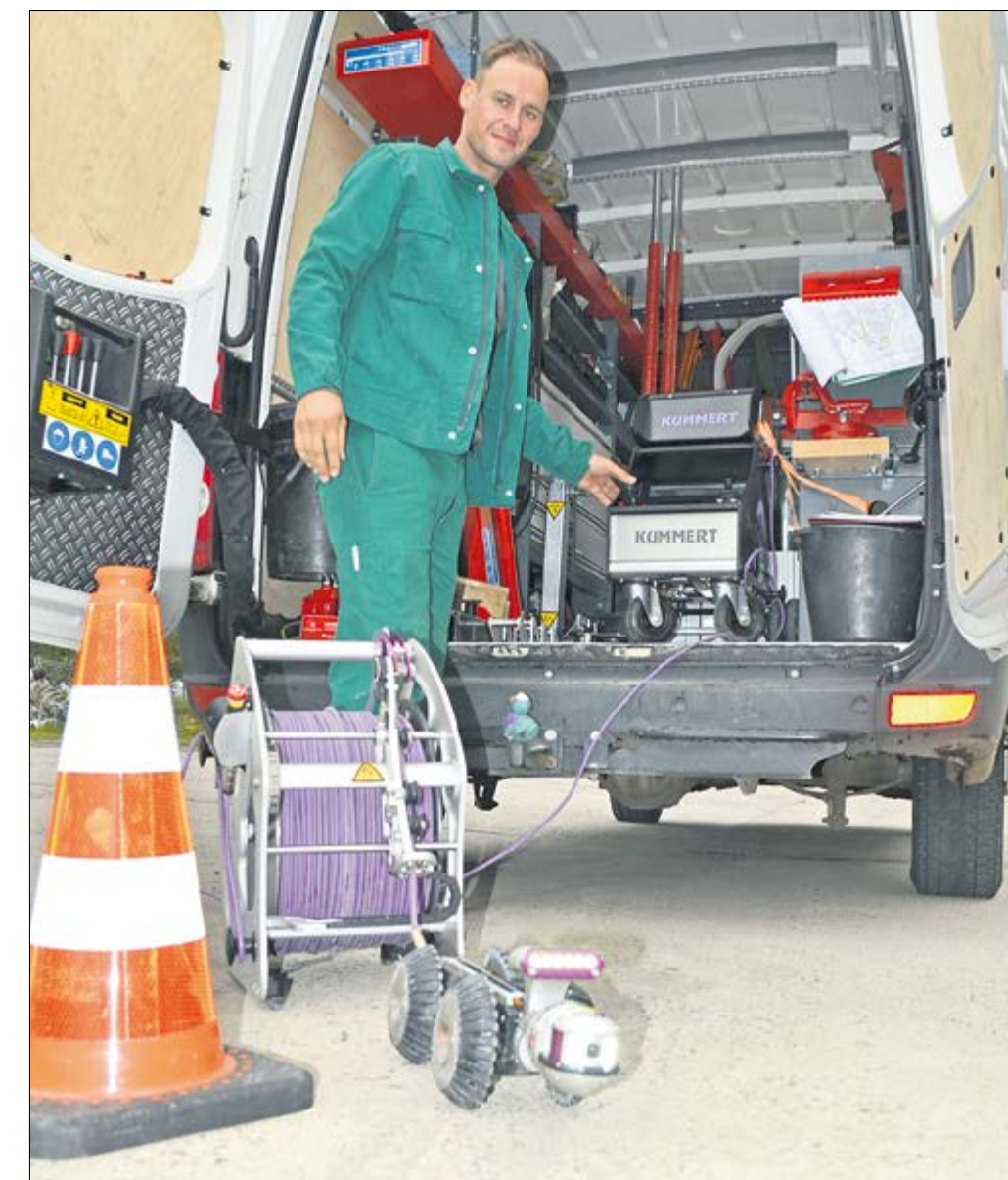
Elektriker Michael Friedrich steuert die Kamera mittels Joystick durch die Kanäle und wartet das Gerät nach jedem Einsatz.
