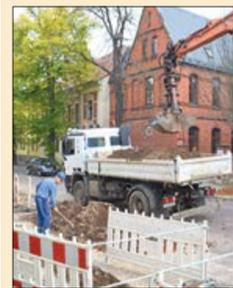
Für die Gasleitungen waren Schachtarbeiten nötig. Der Abwasserkanal konnte grabenlos saniert werden.
