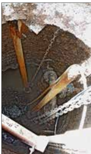
Blick in einen stark angegriffenen Pumpwerksschacht.
