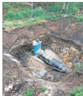
Der Anschluss an die Druckleitung wird freigelegt.
