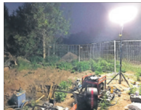
Beim nächtlichen Einsatz wird der leere Strang entkoppelt.
