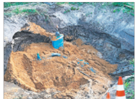
Das Y-Bauteil verknüpft die neue Leitung mit der Hauptdruckleitung.
