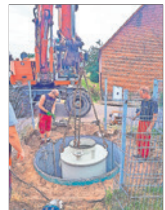
Vor dem Einbau des Behälters in das Pumpwerk Stegelitz kam es zu Messfehlern.
