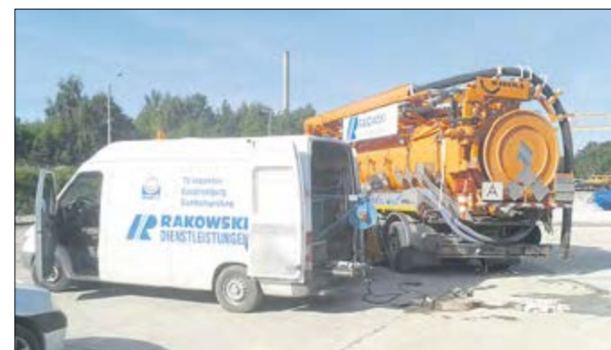
Die Firma Rakowski Dienstleistungen wird sämtliche Kanäle in Möckern mit ihrem Kamerafahrzeug (links) auf Schäden untersuchen. Foto: Rakowski
