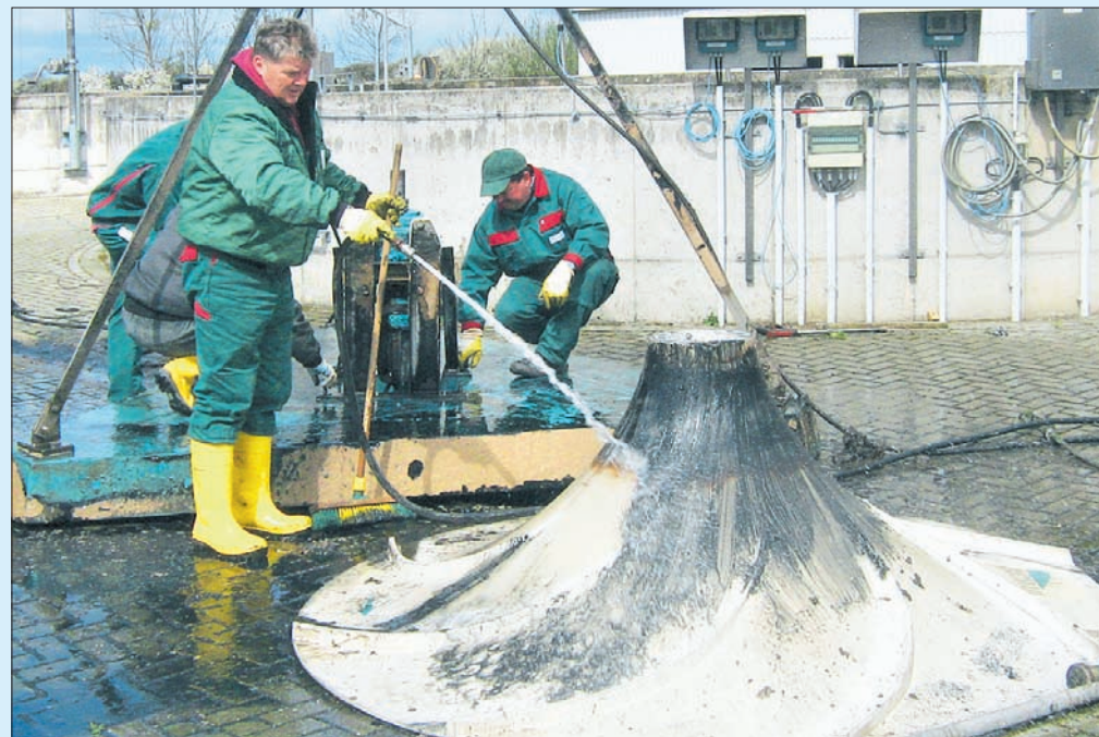
Die Abwasserspezialisten der Heidewasser GmbH mussten die einzelnen Teile des Rührwerks zunächst vom Schmutzwasser reinigen, bevor sie untersucht werden konnten.
