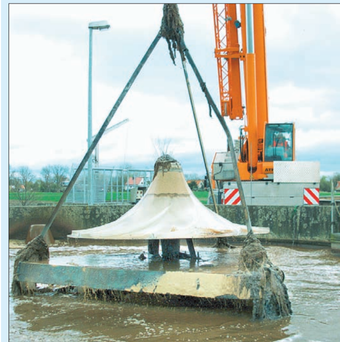
Ein Autokran hob das tonnenschwere defekte Rührwerk aus dem Denitrifikationsbecken der Kläranlage Loburg.
