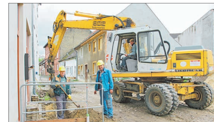
Die Heidewasser GmbH lässt Leitungen für ihre Kunden erneuern.
