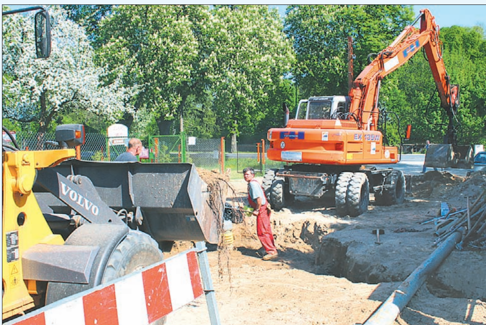
Kundenservice in der Tiefe: AWZ erneuert 2011 wieder Schmutzwasserkanäle im Verbandsgebiet.
