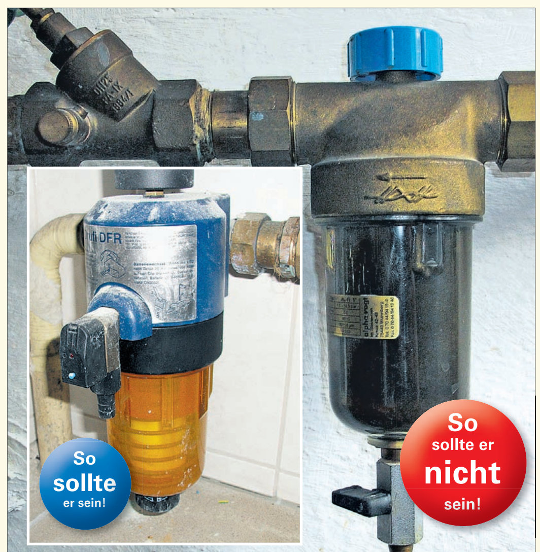
Hell und durchsichtig, wie auf dem linken Foto, sollte der Filtereinsatz aussehen! Rechts ist er verdeckt.
