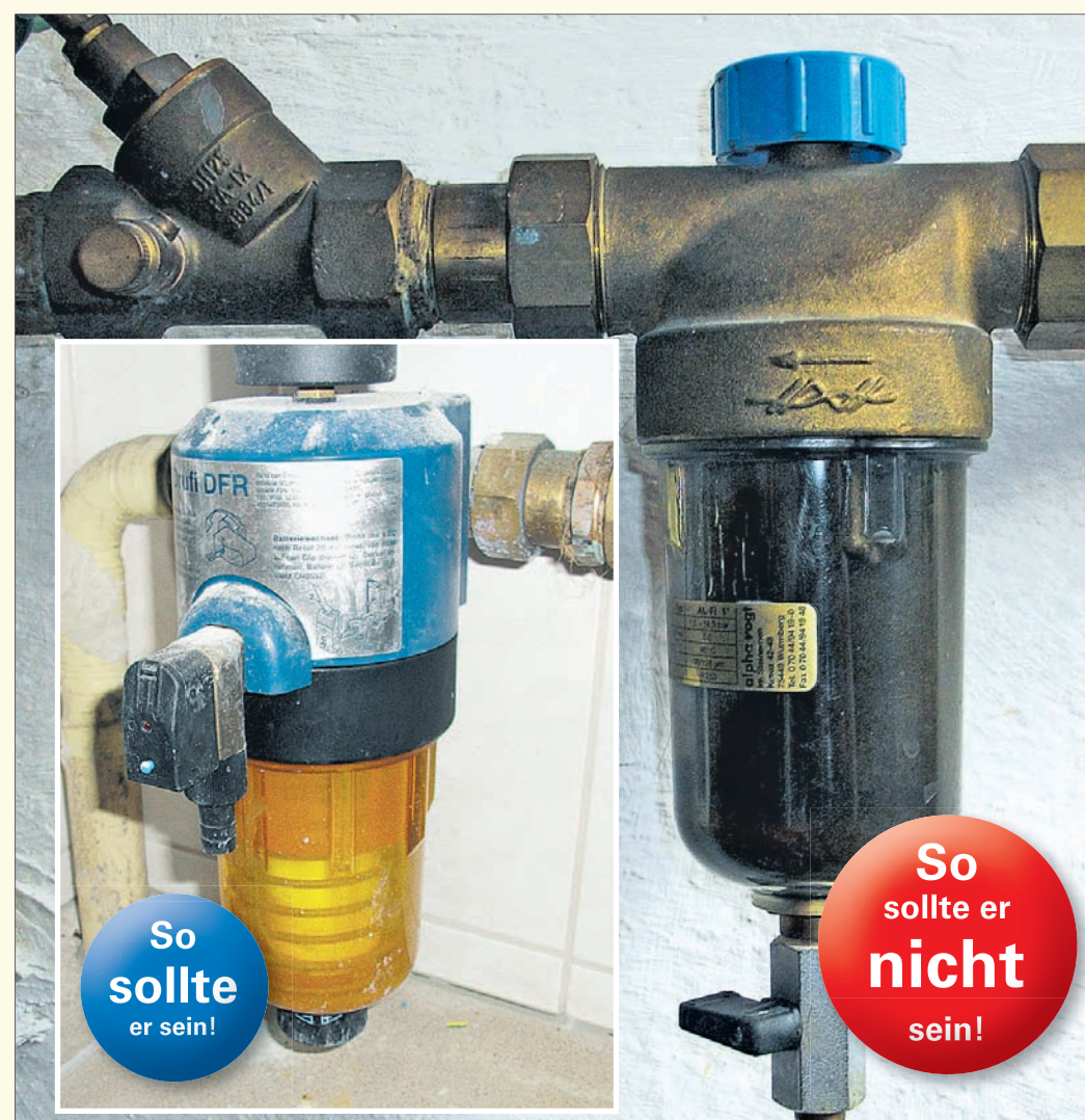
Hell und durchsichtig, wie auf dem linken Foto, sollte der Filtereinsatz aussehen! Rechts ist er verdeckt.
