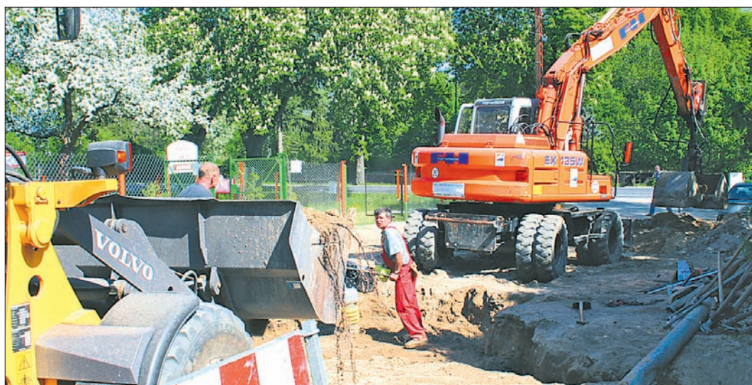
Zwei Baumaßnahmen will der Heidewasser-Meisterbereich Möckern in diesem Jahr realisieren. In Gommern soll in der Albert-Schweitzer-Straße ebenso wie in Zeppernick in der Loburger Straße die Trinkwasserleitung erneuert werden. Der Baubeginn hängt in Zeppernick vom geplanten Straßenausbau ab.
