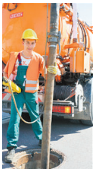
Carsten Schulze beim Kanal-Reinigen vor der Kamerabefahrung.
