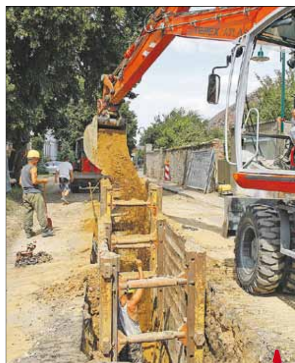
In der Schackensleber Hauptstraße wurde der Schmutzwasserkanal bereits verlegt.
