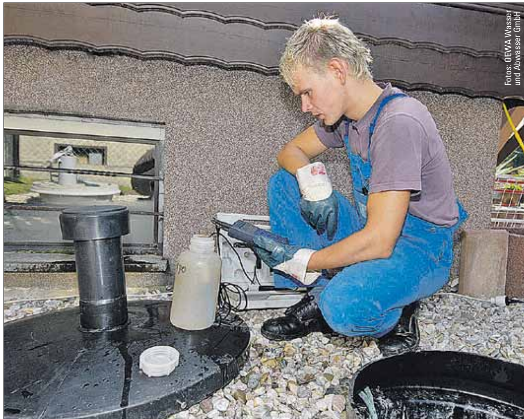
Kleinkläranlagen müssen ökologische Standards erfüllen und regelmäßig gewartet werden. So zum Beispiel werden Temperatur und pH-Wert des Abwassers regelmäßig gemessen.
