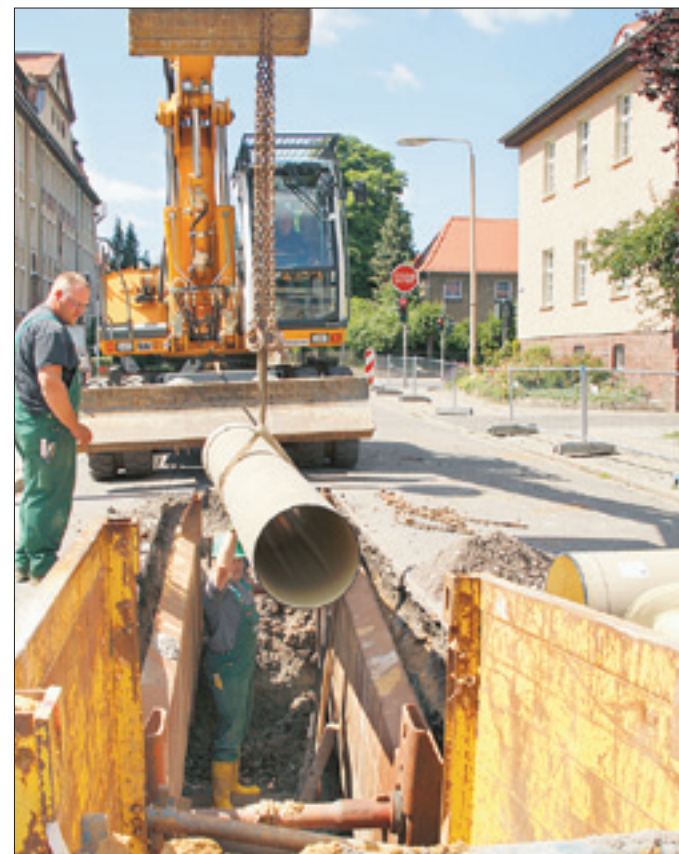
Durch dieses Teilstück eines neuen Kanals in der Haldensleber Schulstraße soll bald Mischwasser (Schmutz- und Regenwasser) fließen.
