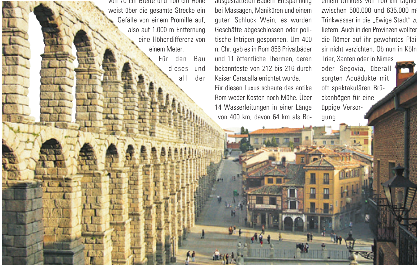
Die 730 m lange Brücke im spanischen Segovia gehörte zu einem 18 km langen Aquädukt, das Wasser in die Stadt brachte. Dieses Meisterwerk römischer Baukunst aus dem 2. Jh. n. Chr. ruht auf 118 Bögen aus Granitsteinen.
