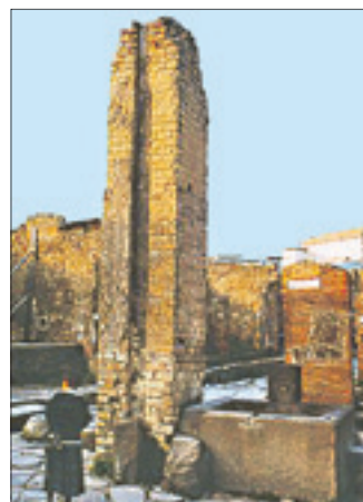
Ein antiker „Wasserturm“ aus Pompeji.
