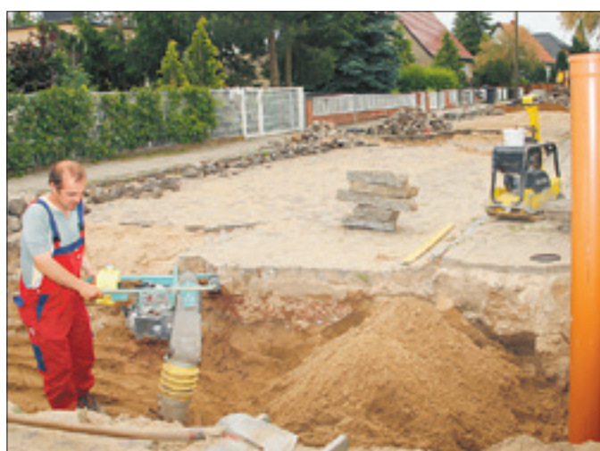
26 Hausanschlüsse in der südlichen Karl-Marx-Straße sind bereits gelegt. Diese Anwohner entsorgen nun über das zentrale Netz.
