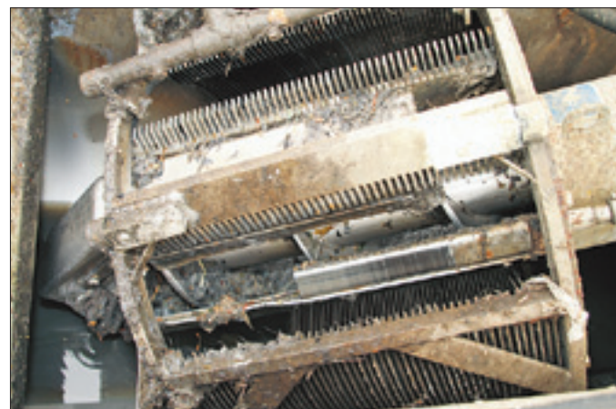
Dieser Rechen ist das Herz der Fäkalannahmestation.
