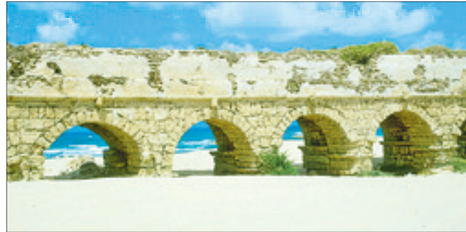
Römisches Aquädukt bei Caesarea in Palästina (ca. 1. Jh. n. Chr.). Die Leitungen bestanden meist aus Stein, wobei auch Holz, Leder und Blei zum Einsatz kamen.
