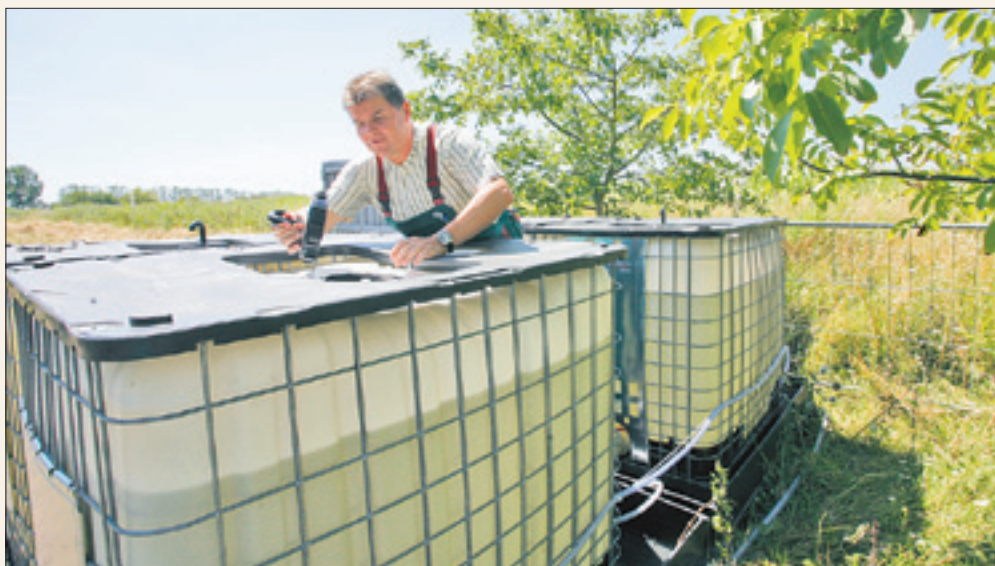
Heidewasser-Mitarbeiter Frank Schönrock prüft die Nutriox-Anlage in der Zeddenicker Schulstraße.
