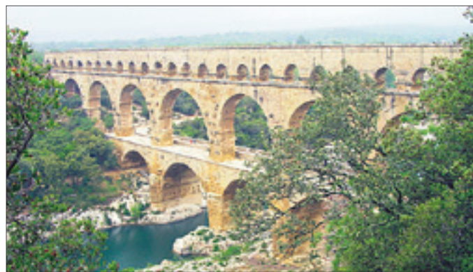
Der zwischen 40 und 60 n. Chr. errichtete 50 m hohe Pont du Gard bei Nimes ist wohl das bekannteste Brücken-aquädukt der Römer. 40.000 m 3 Wasser wurden hier täglich nach Nimes transportiert.
