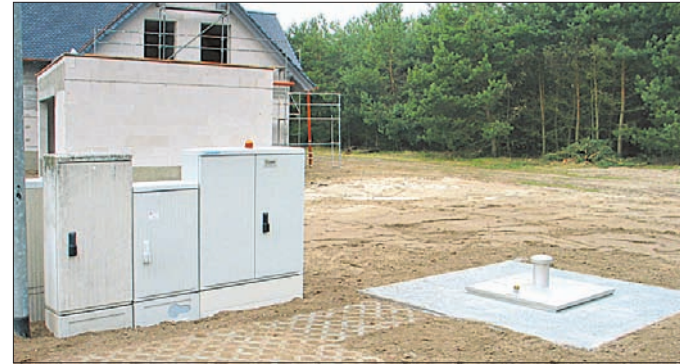
Blick ins Wohngebiet: Über der Erde kaum zu sehen, aber im Untergrund arbeiten große Anlagen, um das Abwasser durch die Leitungen zu pumpen.
