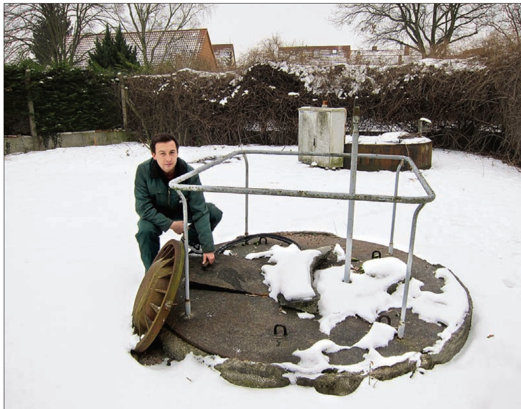
Sanierungsbedürftig: Das Pumpwerk am Kellerberg in Gommern stammt aus dem Jahr 1984. Carsten Schulze von der Heidewasser GmbH hebt die defekte Abdeckung des Pumpwerkvorschachtes.
