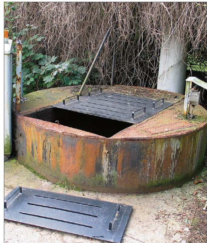
Im 7,50 m tiefen Schacht sammelt sich das Schmutzwasser, das die Pumpen entsprechend des Füllstandes weiter leiten.
