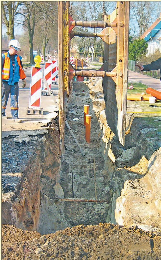
Um die Baugrube zu sichern, wird eine Spundwand eingezogen. In Nedlitz wurde bereits damit begonnen, Schmutzwasserkanäle zu verlegen.
