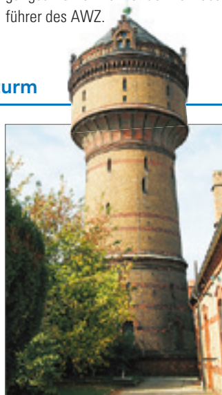
Der Zerbster Wasserturm.
