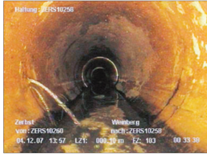
Diese Aufnahmen der Kanalkamera zeigen deutlich schwere Mängel im Zerbster Entsorgungsnetz, wie z. B. eindringendes Wasser am Weinberg (großes Foto) oder Wurzeleinwuchs im Kanal unter der Pulsfordaer Straße (kleines Foto).
