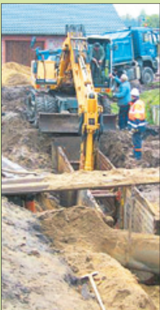
Bau des Schmutzwasserkanals in Bebertal inklusive Querung des Baches „Beber“ für den Anschluss an die Pumpstation „Wellenbergstraße“.
