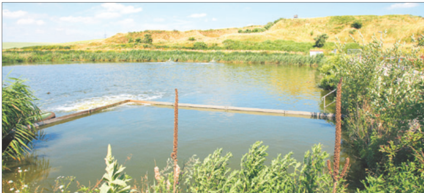
Die Teichkläranlage Nordgermersleben könnte künftig die Abwässer von Eimersleben, Erxleben, Hakenstedt und Uhrsleben reinigen.
