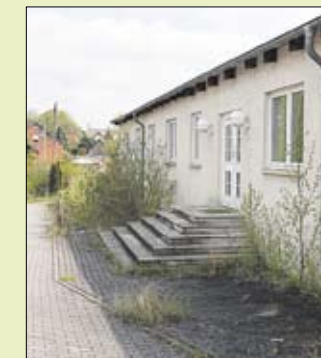
Der gegenwärtige Zustand des gekauften Gebäudes.
