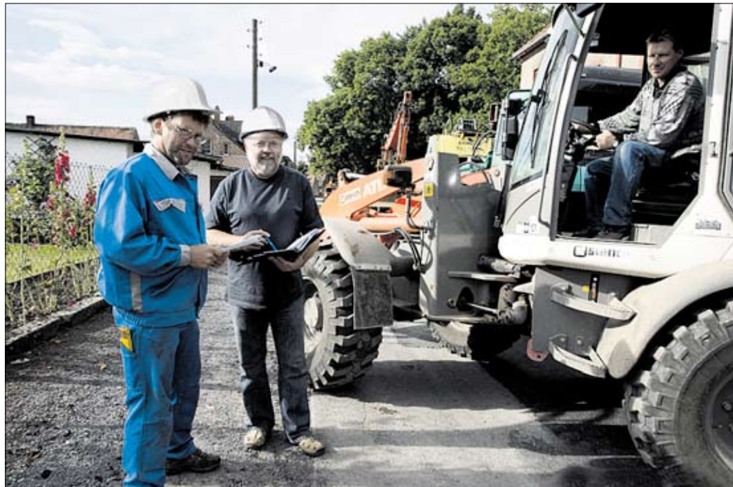
Uwe Buchmann (links im Bild) und Bereichsleiter Hartmut Greupner, Fa. Rakowski, auf der Baustelle in Emden.
