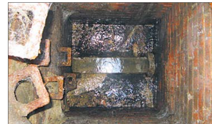
Dieser Abwasserschacht ist einer von mehreren durch die Grundwasser eindrang, das zur Kläranlage Rätzlingen floss.
