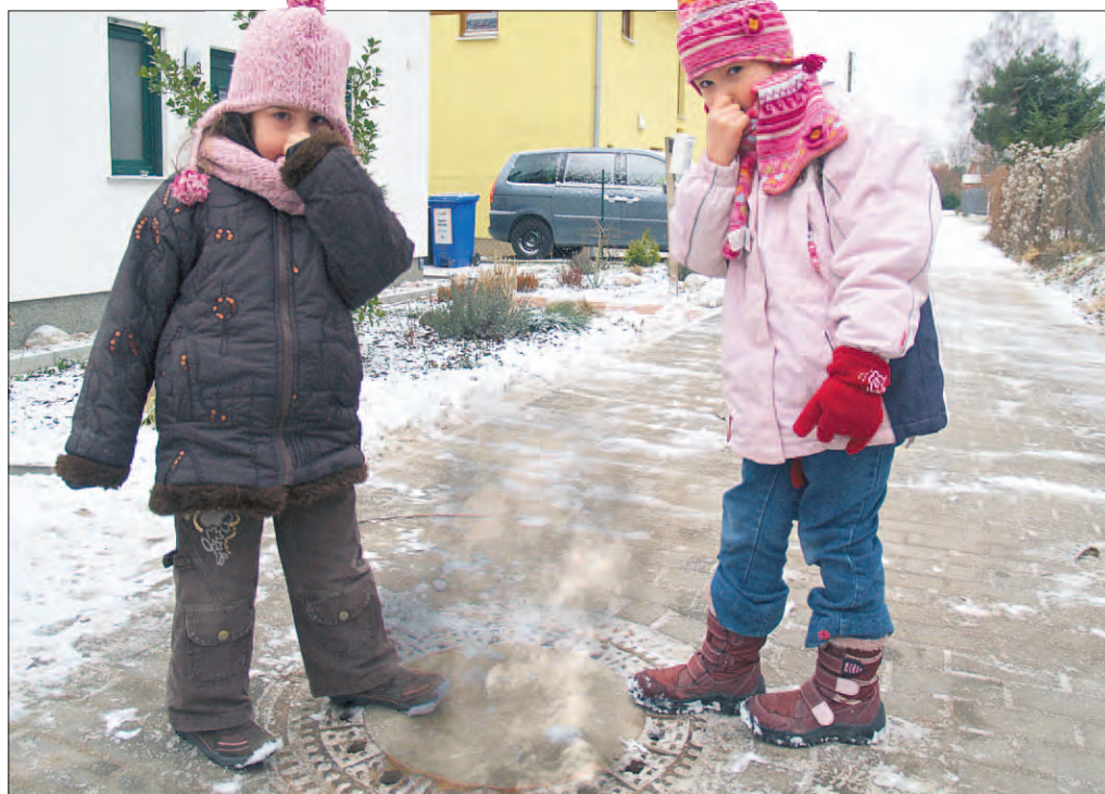
Auch ein geringer Wasserverbrauch, verbunden mit einer grundlegenden Änderung der Abwasserinhaltsstoffe und der viel längeren Verweilzeiten im Kanalnetz, verursacht unangenehme Gerüche.
