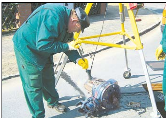
Die Reparatur verstopfter Pumpen ist sehr aufwändig.
