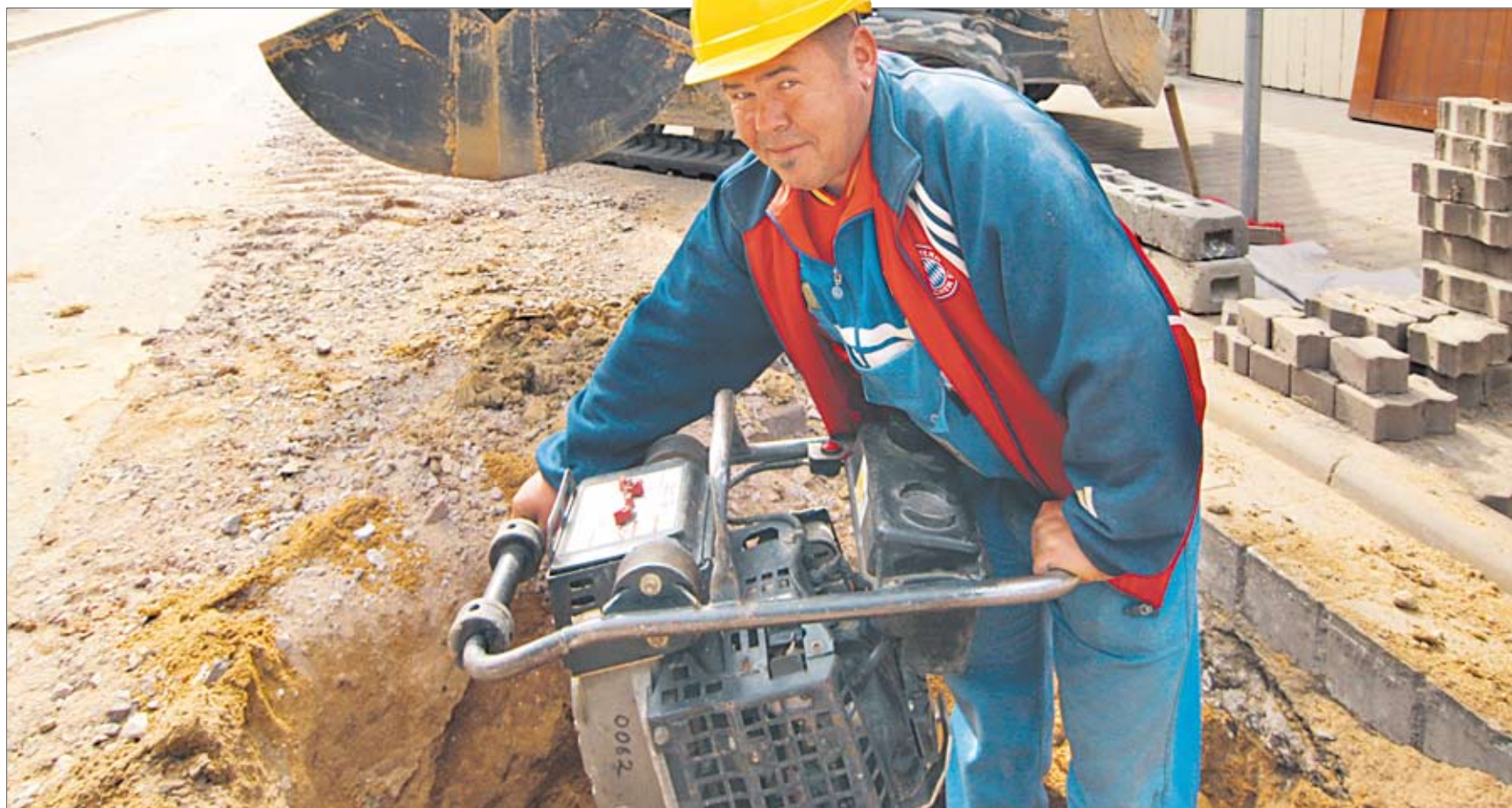
Liegen die neuen Leitungen im Hausanschlusschacht, heißt es alles wieder dicht zu machen. Udo Klinge, ITB Schönebeck, nimmt dafür den Grabenverdichter zu Hilfe. Zuvor hatte das Team in der Hauptstraße in Bregenstedt Abwasserleitungen verlegt.
