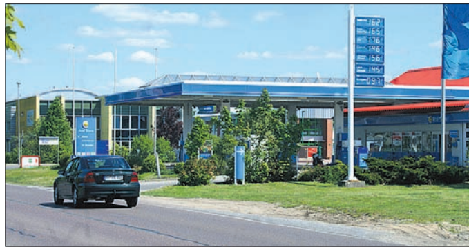
Bei Gewerbebetrieben – wie z. B. Tankstellen – fällt besonders belastetes Abwasser an. Darüber muss der Abwasserverband Bescheid wissen.
