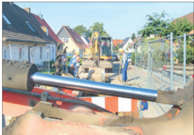
In der Unteren Straße in Hillersleben wurde als erstes mit der Verlegung des neuen Mischwasserkanals begonnen.
