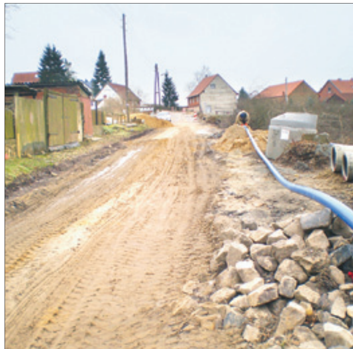
Der erste Bauabschnitt der Verlegung einer Trinkwasserleitung in Walbeck wurde in diesem Jahr planmäßig abgeschlossen.
