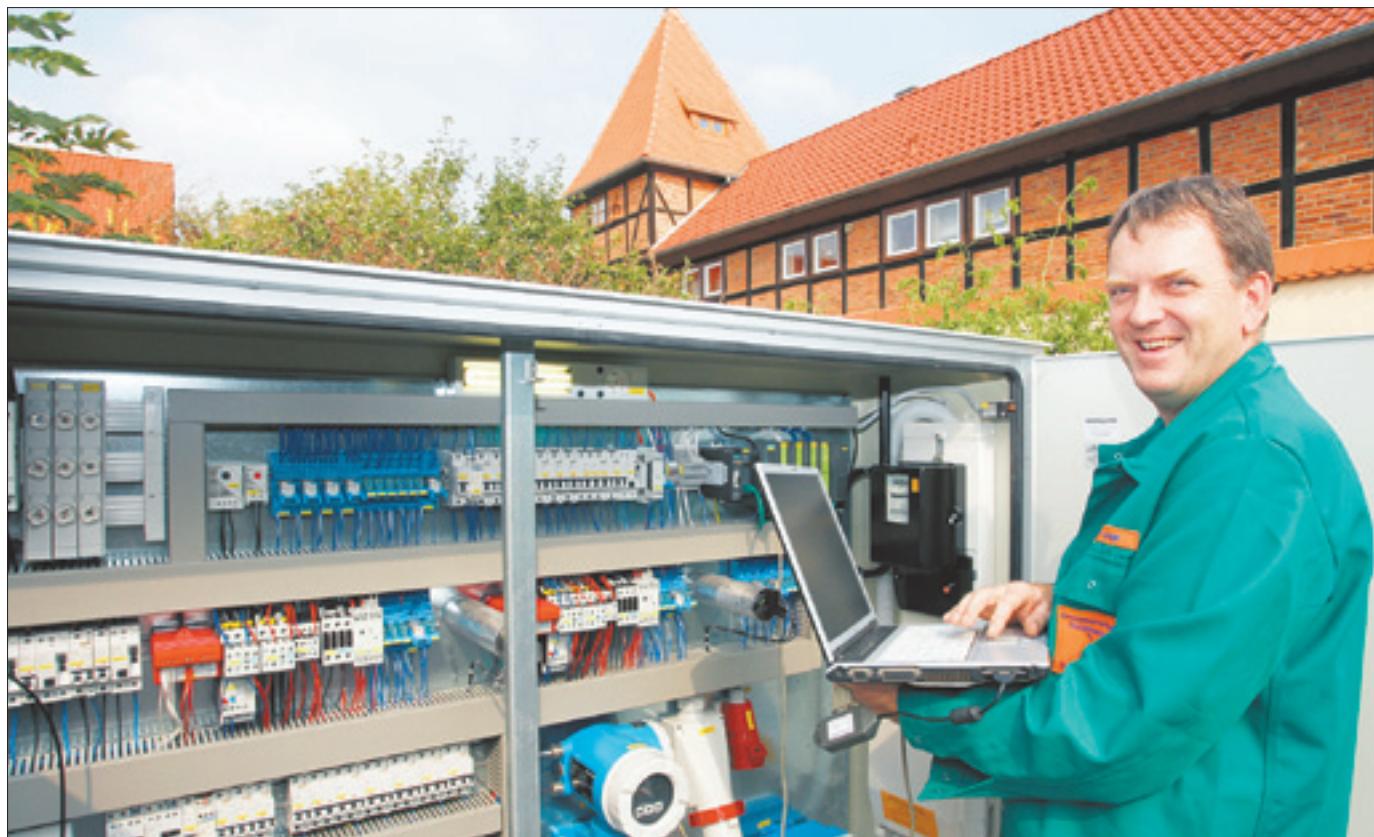
Dank moderner Technik kann Thomas Lange ein Pumpwerk wie das in der Haldensleber Großen Straße per Laptop bedienen.
