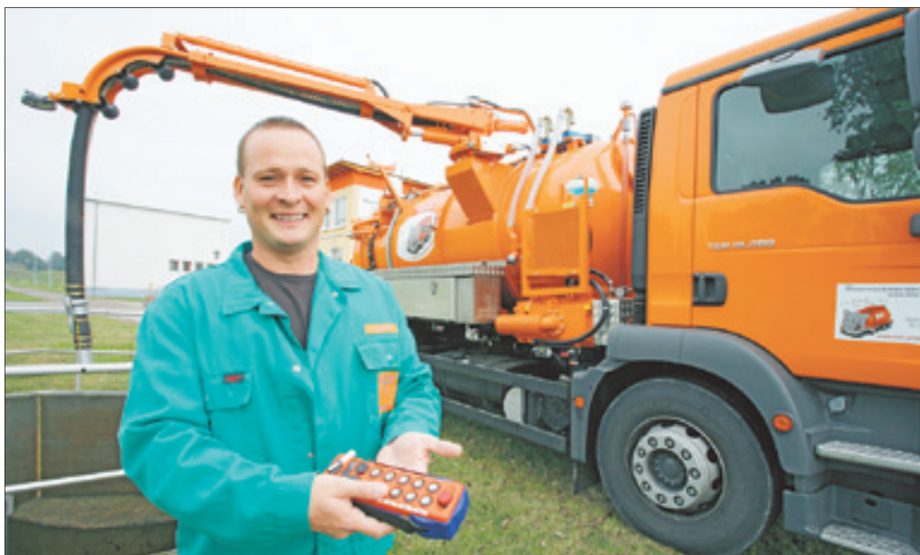
Fernbedienung für den Saugwagen: Kanalarbeiter Mike Lindner arbeitet mit der neuesten Technik.
