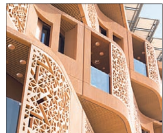
Fassade des Masdar-Institutes.
