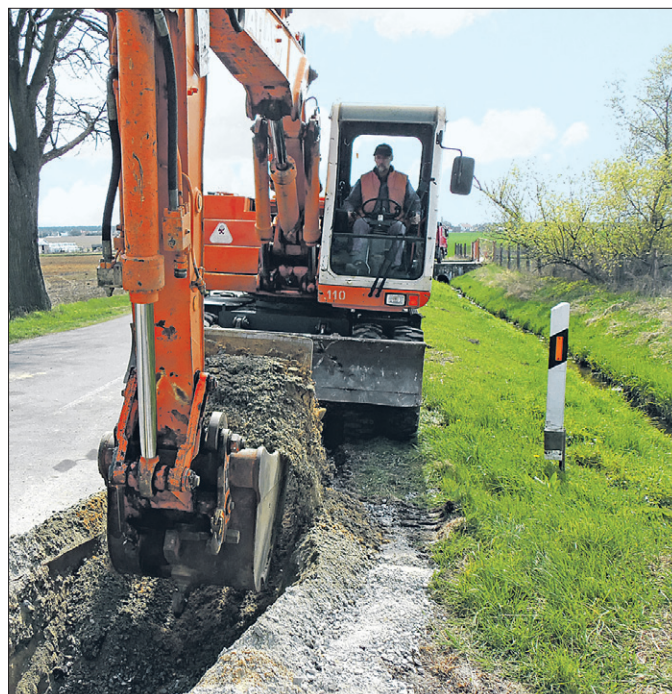
Die Arbeiten beginnen in der Bahnhofstraße am Kanalanschlusspunkt. Die Leitungen führen von dort zur Kläranlage Rätzlingen.
