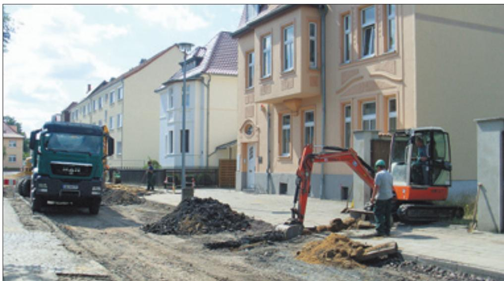
Außerdem sind für dieses Jahr in Haldensleben der Bau eines Mischwasserkanals (DN 500) mit 170 m Länge, inklusive acht Hausanschlüssen, in der Schulstraße, eines Mischwasserkanals (DN 300), 90 m lang mit 14 Hausanschlüssen in der Stendaler Straße, und der 1. Bauabschnitt für einen 270 m langen Regenwasserkanal (DN 600) in der Neuhaldensleber Straße geplant.
