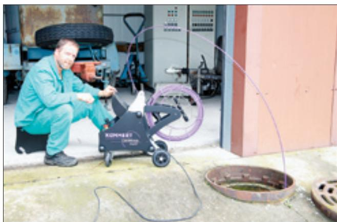
**Henning Wilke sucht mit der Kamera einen Kanal nach Verstopfungen ab. 60 m kann diese in den Kanal fahren. „Aale“ heißen die Verbindungsstücke zwischen Kamera und Grundgerät. Der Kopf der K-70 hat einen Durchmesser von 70 mm, einen Schwenkbereich von 125 Grad und dreht sich automatisch immer wieder in die Horizontale.**
