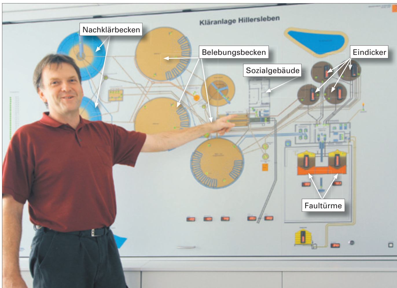
Thomas Lange, Verantwortlicher für die Elektrotechnik auf der Kläranlage in Hillersleben, erklärt die Schalttafel Abwasserreinigungsanlage.
