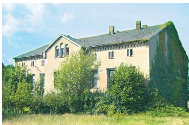
Das Gutshaus Hasselburg war seit seiner Erbauung 1870 u. a. Jagdschloss, Gaststätte, Bibliothek und Schwesternstation.
