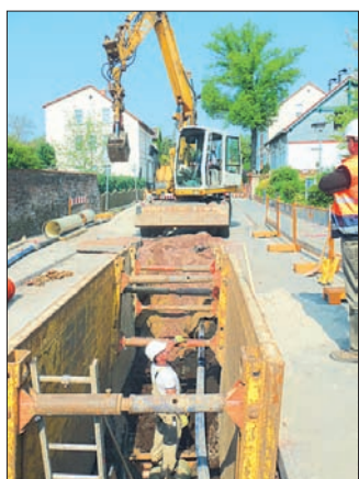
Neuer Mischwasserkanal für die Kolonie Haldensleben.
