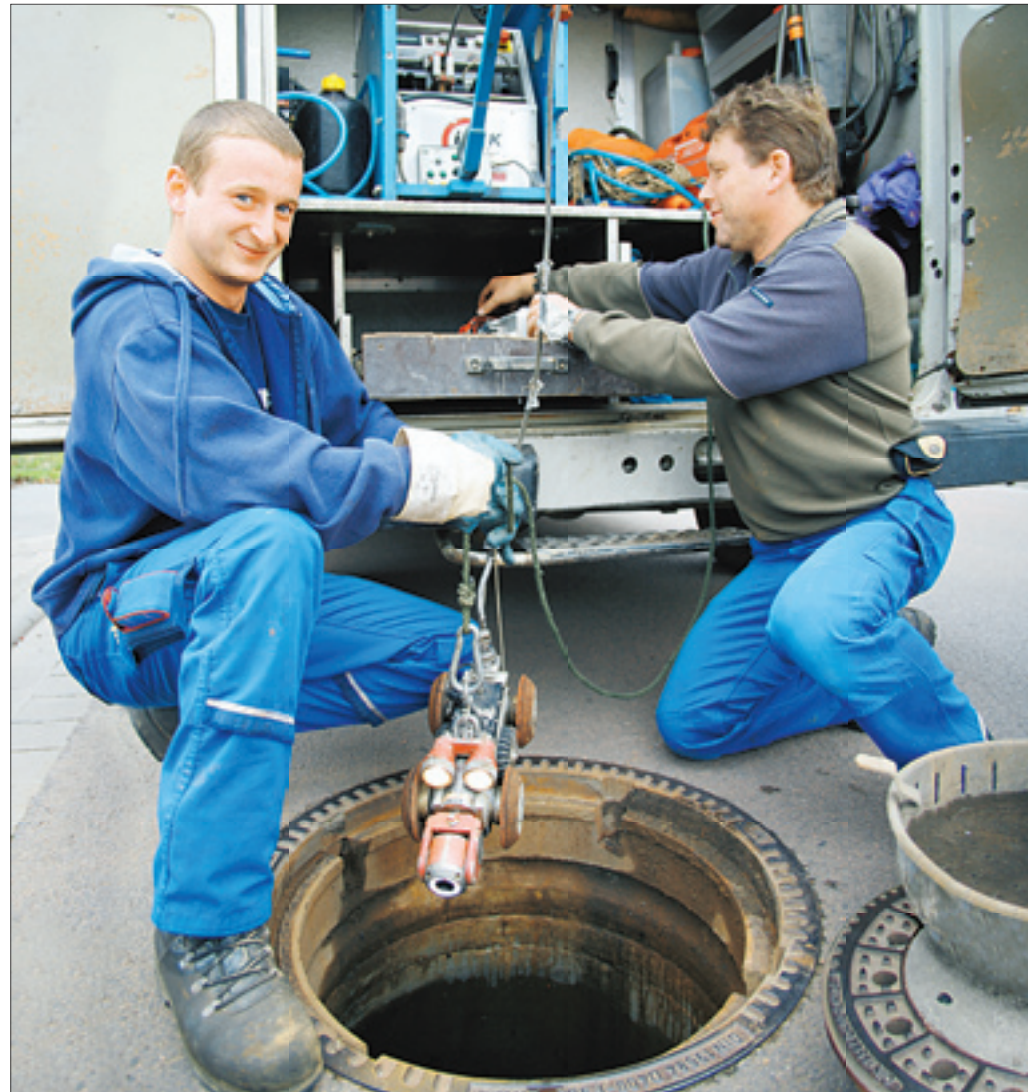
Die Kanalinspektoren Marcus Keil (links) und Uwe Buchmann von der Firma Rakowski filmen das Zerbster Abwasserkanalnetz Stück für Stück mit dieser Kamera.
