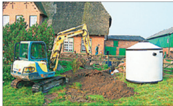
Die Entsorgung über eine Kleinkläranlage wird billiger.
