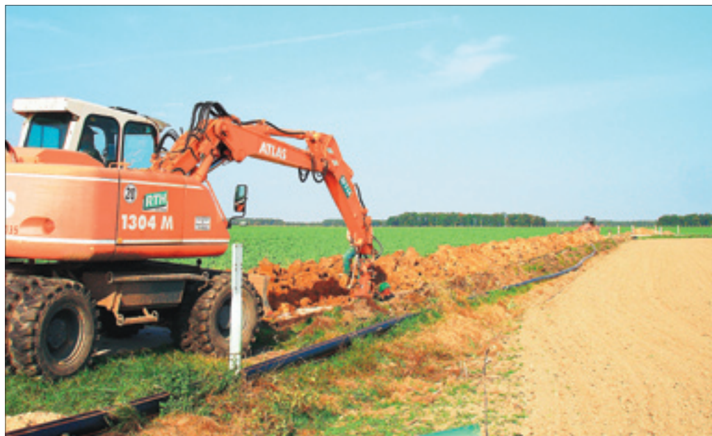
Insgesamt 9,2 km Abwasserdruckleitung wurden zwischen Nedlitz und Lindau verlegt.
