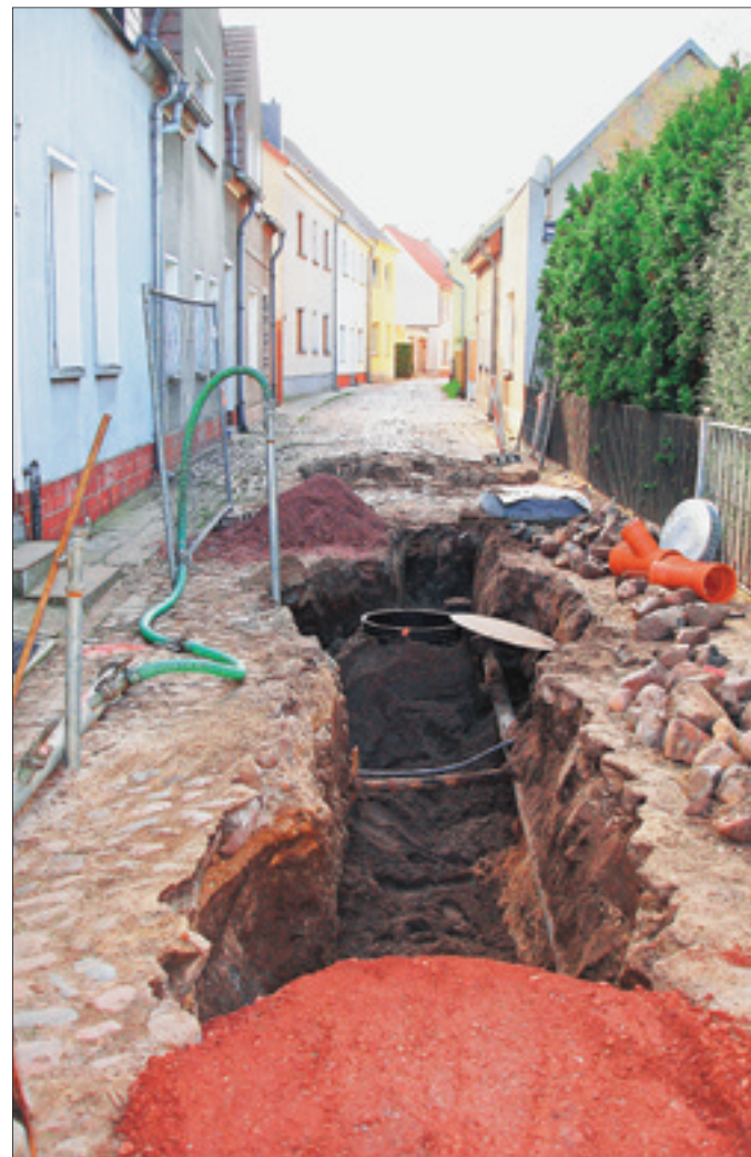
In der Zerbster Marktstraße ließ der AWZ Elbe-Fläming einen Schmutzwasserkanal in den Boden einbringen.
