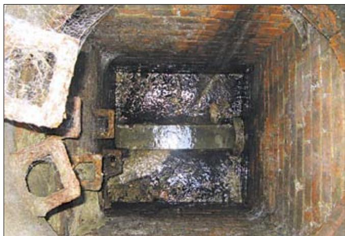
Dieser Abwasserschacht ist einer von mehreren, durch die Grundwasser eindringt, das zur Kläranlage Rätzlingen fließt. Ein Indiz dafür sind die Flächen neben der Kanalrinne. Sie müssten trocken liegen, sind jedoch nass.
